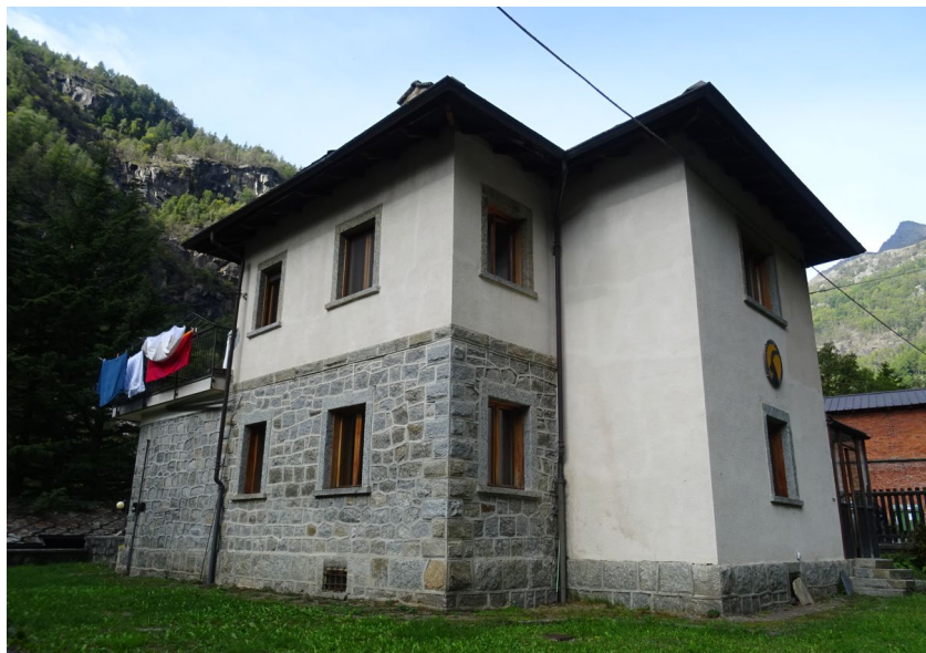
Figura 4 - Vista da Nord Est – Foto 3 (da strada)
