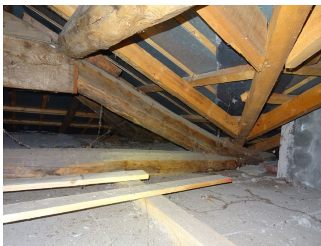
Figura 5 - Sottotetto non riscaldato dell'edificio, con feltro isolante all'estradosso
