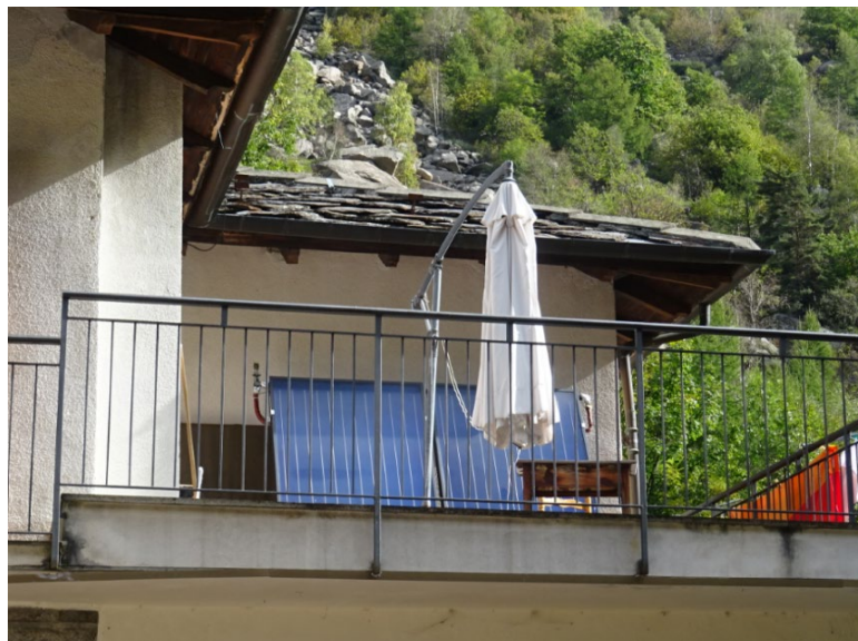
Figura 9 – Collettori solari piani installati sul terrazzo dell'edificio
