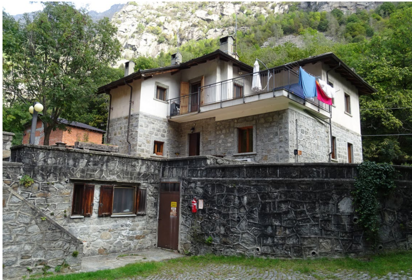
Figura 3 - Vista da Sud – Foto 2 (cortile edificio)
