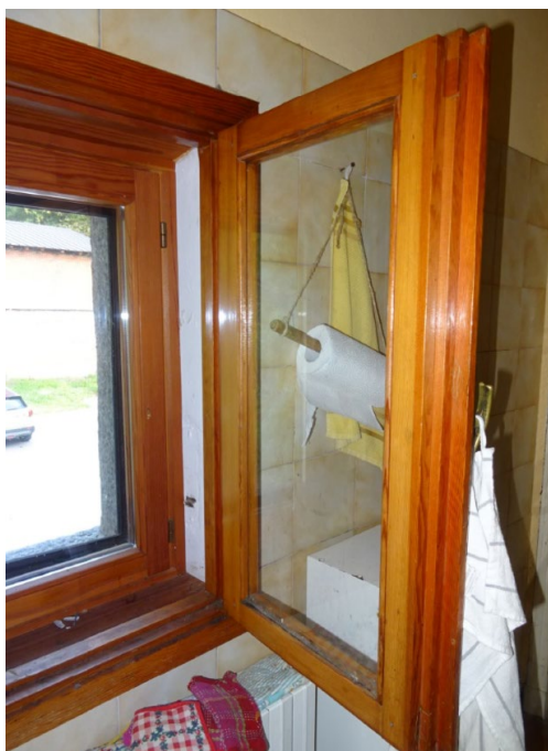
Figura 7 - Finestra tipo dell'edificio, con doppio serramento in legno, vetrocamera (esterno) e vetro singolo (interno)
