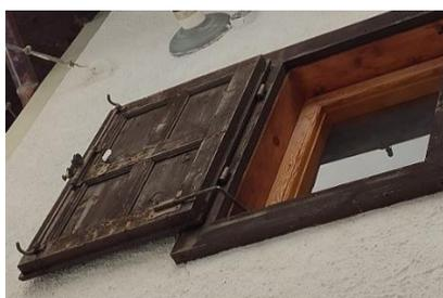
Figura 9 – Telaio in legno esterno per montaggio degli scuri (foto ante operam)
